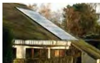
L'ENE s'est mise au solaire. 700 m<sup>2</sup> de capteurs photovoltaïques ont été intégrés à la toiture du manège Cadre Noir. Ils permettront de produire environ 102 000 kWh par an d'électricité. 120m<sup>2</sup> de panneaux solaires thermiques ont été installés sur les toits des écuries pour produire de l'eau chaude.
