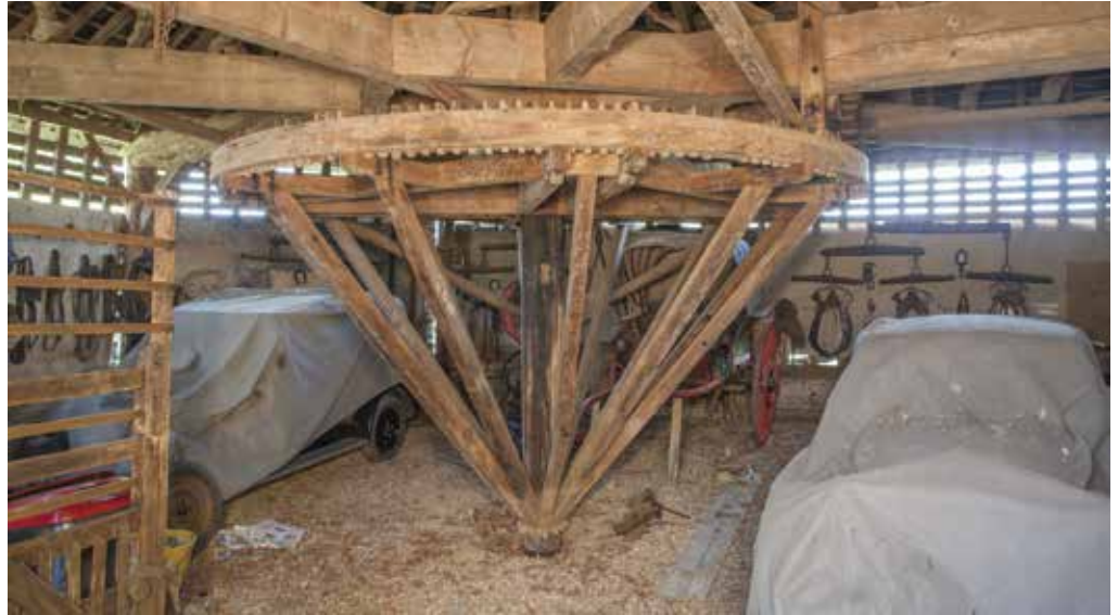
Manège en place sous sa charpente en pays de Caux. Photo Christophe Kollmann, service de l'inventaire et du patrimoine. Région Normandie.
