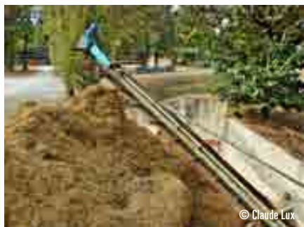
Evacuateur de fumier de l'ENE de Saumur
