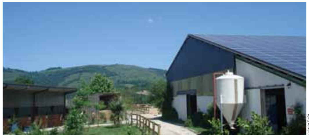
Panneaux photovoltaïques sur le toit, récupérateur d'eau et environnement soigné
